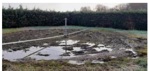
Vue d'un filtre à sable – janvier 2024
